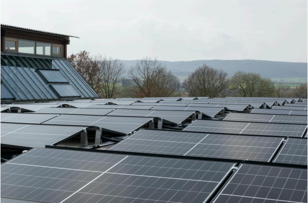
*Auf den Dachfeldern der Wilkhahn-Fertigungshallen wurden auf einer Fläche von 440 m<sup>2</sup> 265 Solarmodule installiert. Foto: Wilkhahn*
